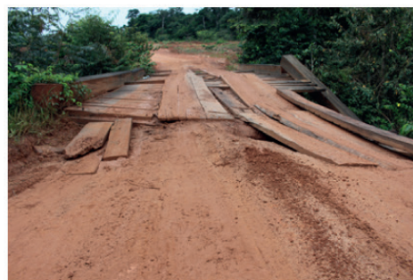
Fotos 3 e 4: Trechos sem manutenção na BR-174 (erosão e ponte danificada).
