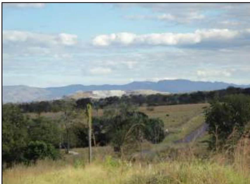
Mina de amianto da SAMA minerações. Ao fundo serra formada por complexo máfico-ultramáfico (Foto: CPRM)
