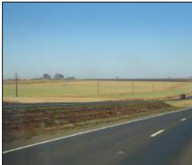
Obra linear (rodovia) sobre relevo plano. Domínio DVM (Fonte: CPRM)
